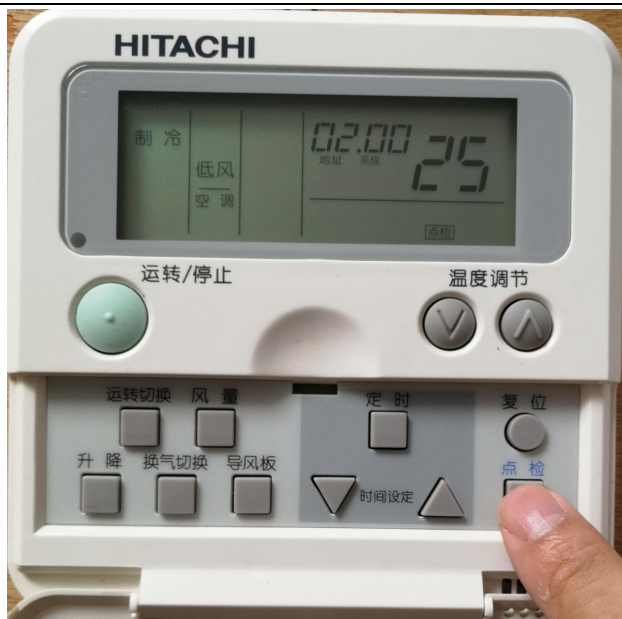
图 7 通过有线遥控器设定日立空调室内机地址
